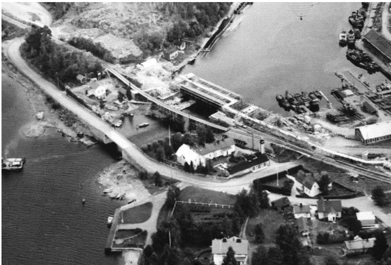
Laitaatsalmen sillat rakenteilla vuonna 1960. Kuva kirjasta Suuri Savontie.
