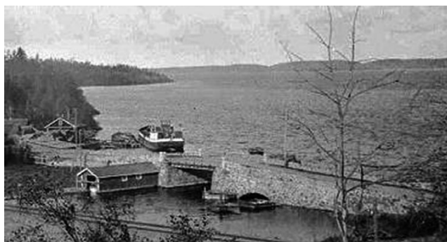
Maantiesillan vasemman holviaukon laajennus on tehty. Toinen kaupungin puoleinen holviaukko on alkuperäisessä asussaan. Lusto / Metsähallituksen Insinööriosaston kokoelma.
