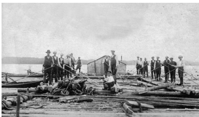
Suman liikuttelussa käytettiin kuluveneitä. Veneet ankkuroitiin rauta-ankkureilla joko vastarannalle tai järveen. Kuluveneet jätettiin paikoilleen pitämään suma määrätynmuotoisena Puiden vierityksen jälkeen tuli niputuskone, hinaaja halkolotjineen ja tervahöyry. Nyt alkoi puiden matka tehtaisiin.
